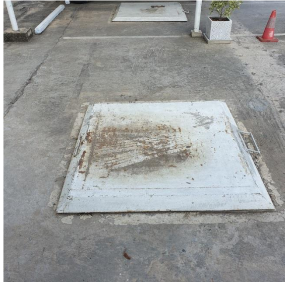
รูปที่ 47 โครงการออกแบบฝาลัง (ช่องคนเข้า) เพื่อให้เจ้าหน้าที่สามารถเข้าไปตรวจสอบ ซ่อมบำรุง จำนวน 2 ฝาลัง โดยตำแหน่งฝาลังอยู่บริเวณพื้นที่จอดรถ
