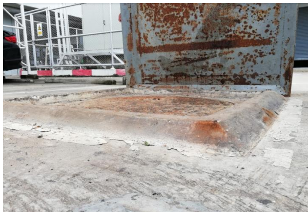
รูปที่ 48 ฝาดังเก็บน้ำของโครงการมีขอบยาง และอยู่สูงกว่าระดับพื้นผิวที่จอดรถ เพื่อป้องกันการปนเปื้อนลงสู่ถังเก็บน้ำ
