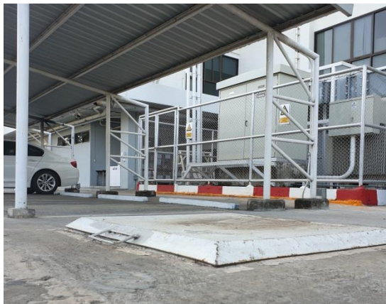
รูปที่ 48 ฝาดังเก็บน้ำของโครงการมีขอบยาง และอยู่สูงกว่าระดับพื้นผิวที่จอดรถ เพื่อป้องกันการปนเปื้อนลงสู่ถังเก็บน้ำ
